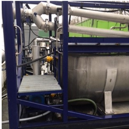
Aanvoer afgassen naar scrubber
