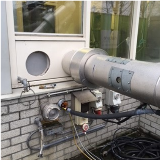
Aanvoer afgassen naar scrubber
