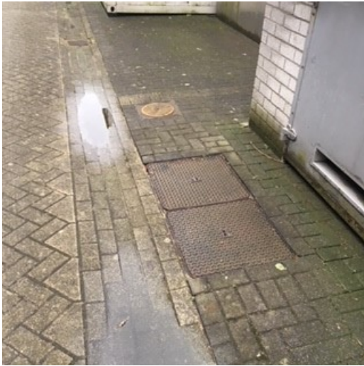
Olie en slibvanger met controleput
