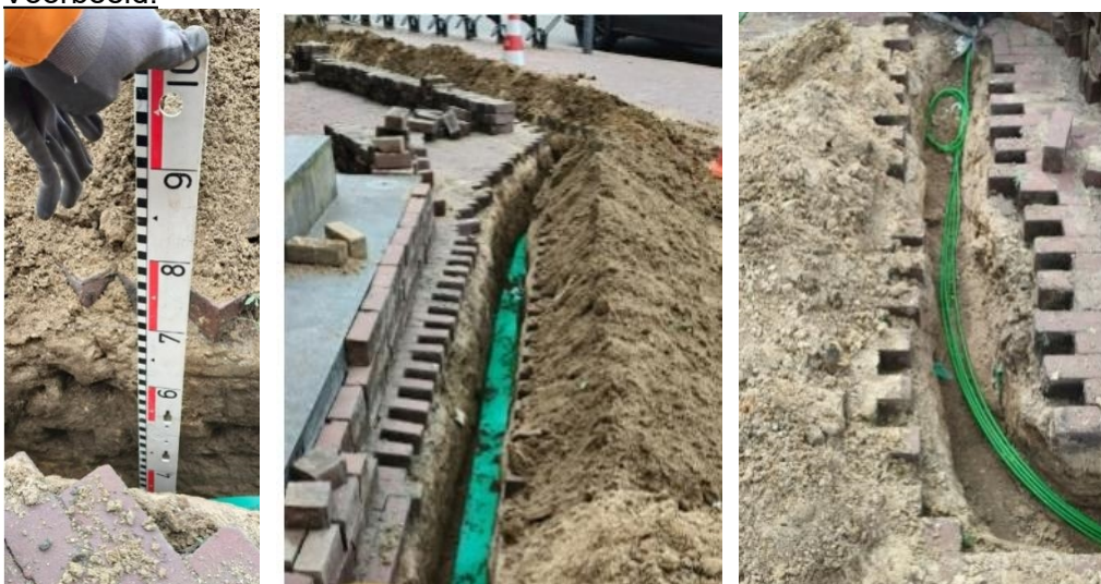
Foto's aanleveren gegraven sleuf.
