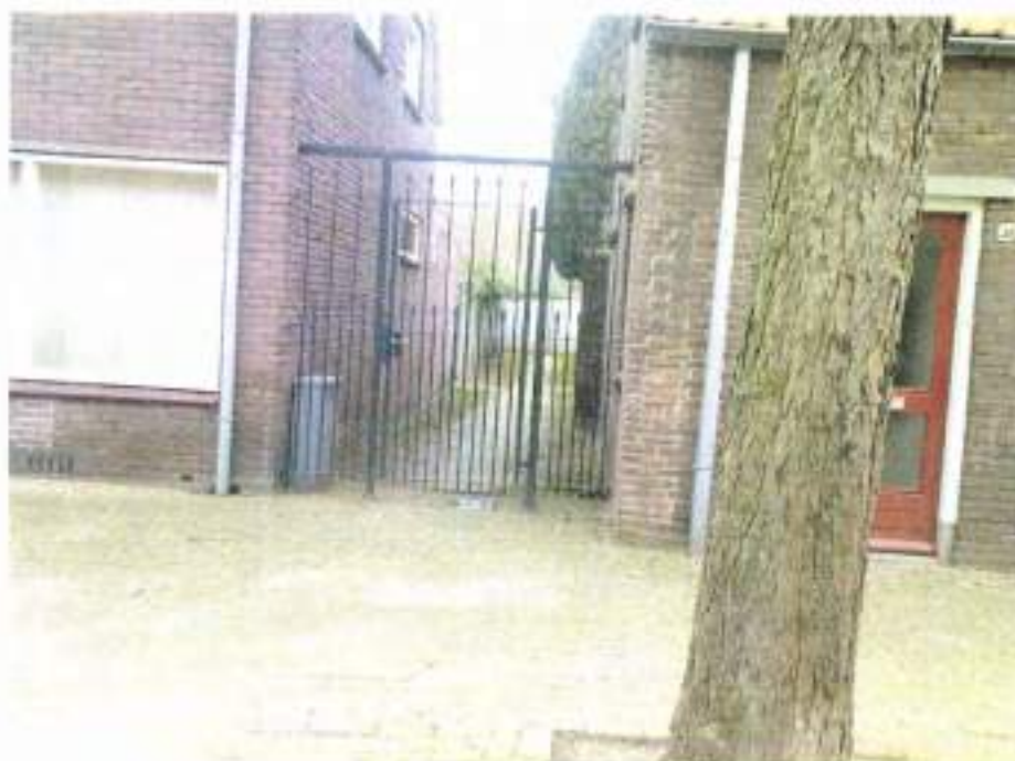
Foto 10 Brandgang met hekwerk Beverstraat
