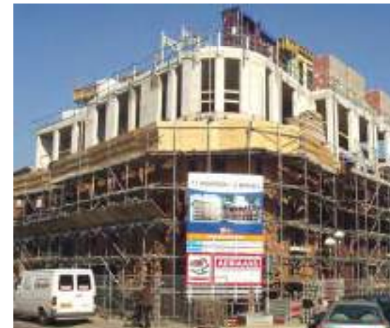
Locatie voormalige Dansschool Commerciële functies, appartementen en atelierwoningen
